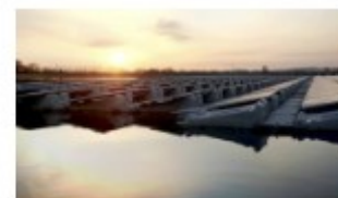
CIEL & TERRE : CENTRALES SOLAIRES FLOTTANTES
